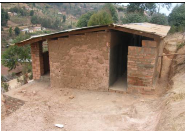
New boys toilet
