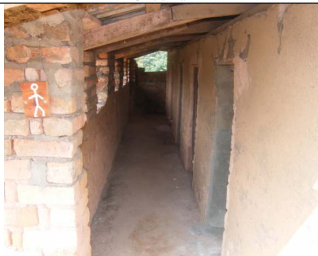
New boys toilet
